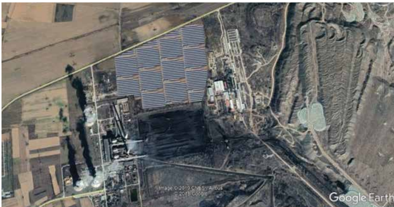
Фотонапонска електрана Битола 20 MW
