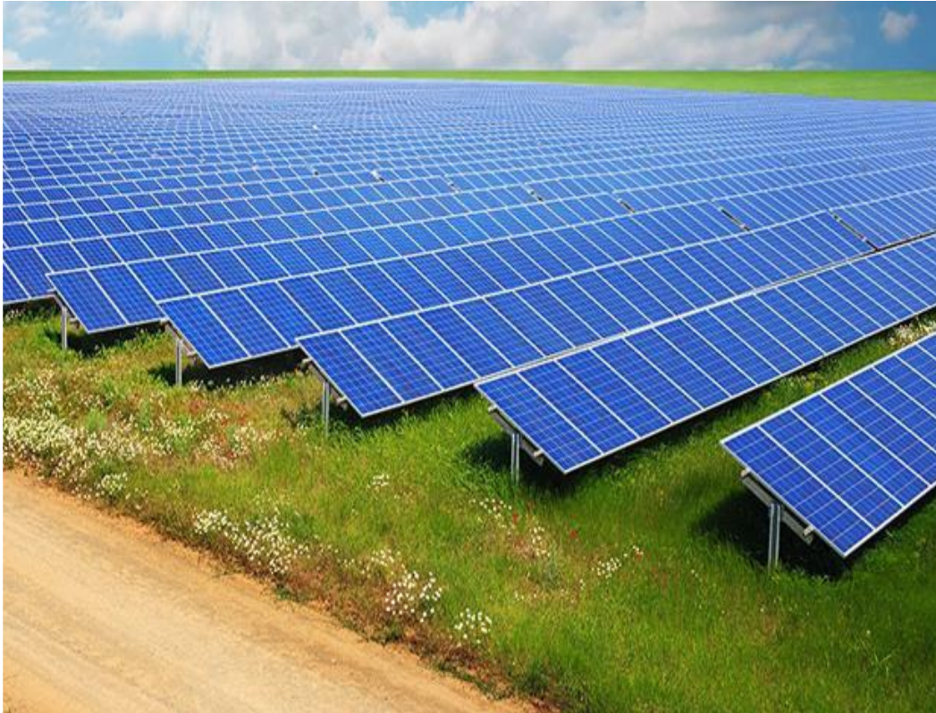
Слика 35. Изглед на фотоволтаична електроцентрала вклопена во локалниот предел
