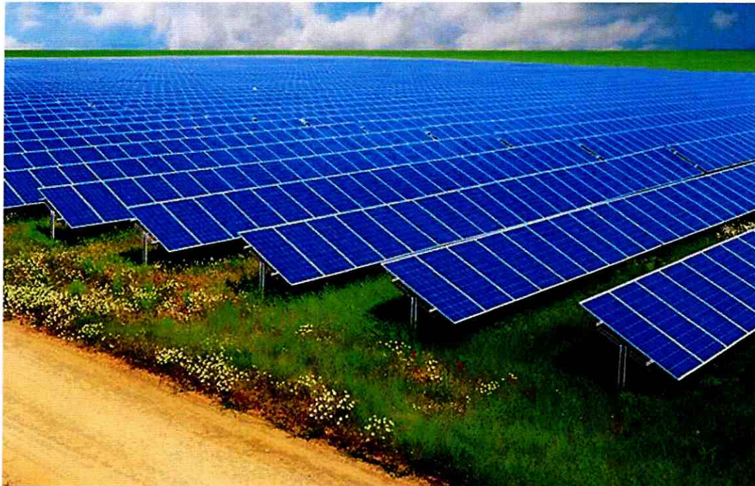
Слика 24 Изглед на фотоволтаична електроцентрала вклопена во локалниот предел
